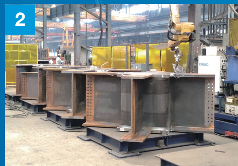
仕口材製作 (ロボット溶接)
