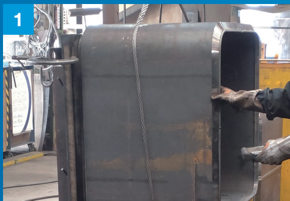
サイコロ材製作 (切断開先品にダイアフラム取付)
